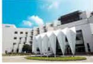
台南研發中心 (鑽石級綠建築)
